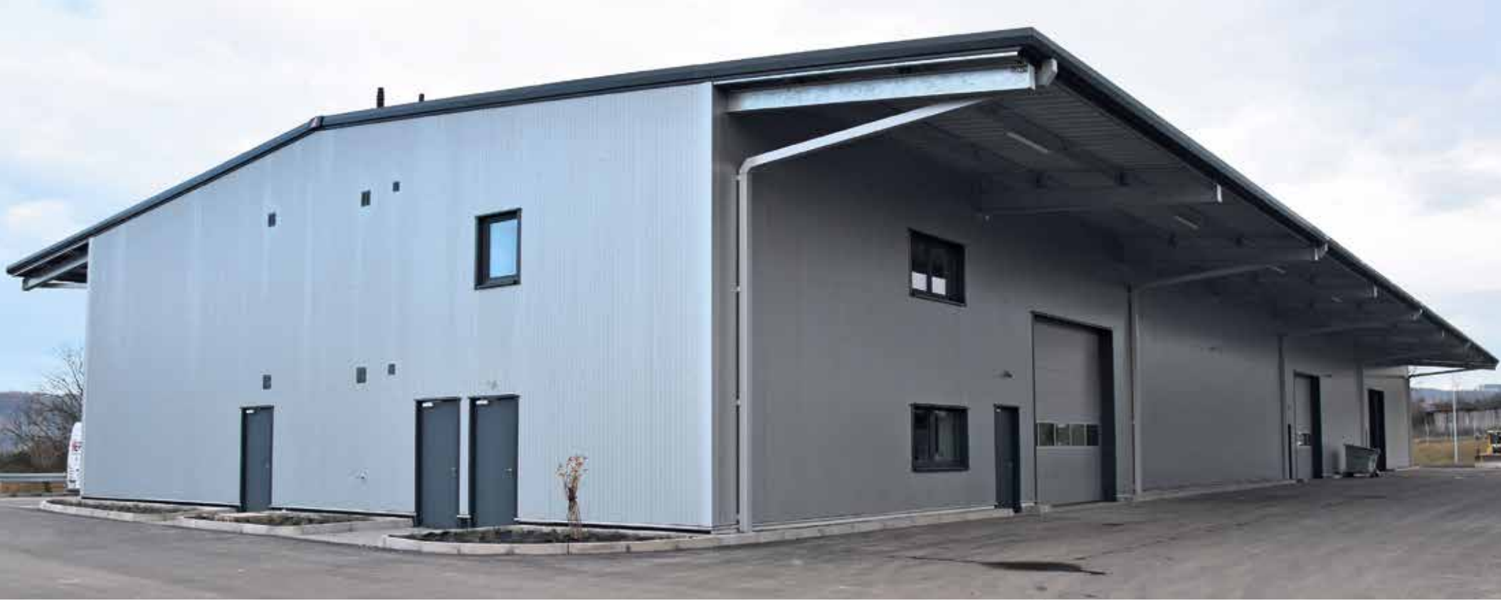
Die neue Lagerhalle
